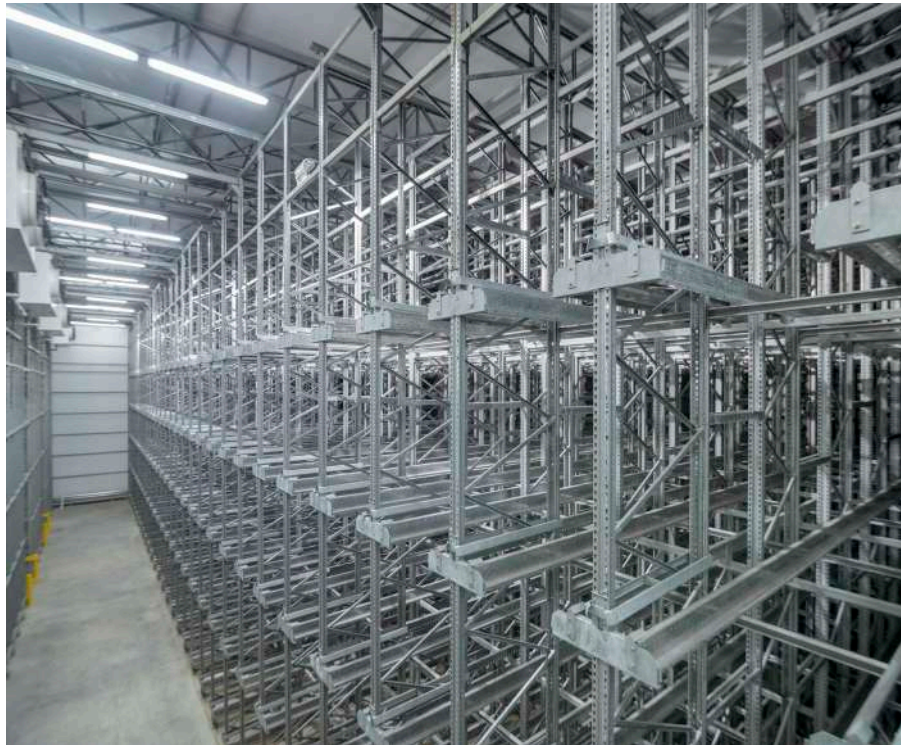
Vue en section de l'entrepôt autoportant de Granja Tres Arroyos
